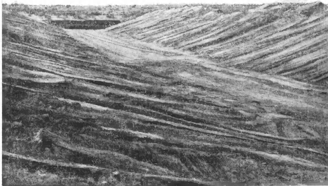
Готовая пионерная траншея, вырытая бульдозером
